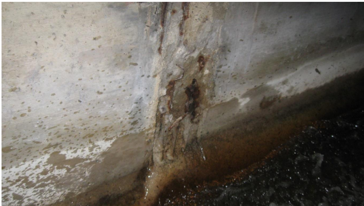
Рисунок 3 – Стык железобетонных труб, выполненный из монолитного бетона в тоннеле ковшового водосброса (водохранилище Кутовщина Барановичского района Брестской области, 2023 г.)
