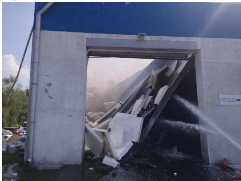
**Рисунок 1 – Вид повреждений здания при дегазации транспортной емкости сжиженного газа при взрыве газовой смеси [3]**
