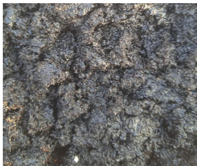
Рисунок 3 – Общий вид предлагаемой ремонтной композиции для выполнения ямочного ремонта
