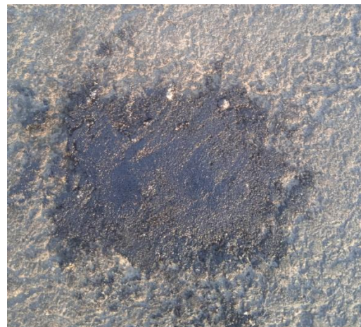
Рисунок 4 – Ямочный ремонт асфальтобетонного покрытия придворовой территории композицией № 9
