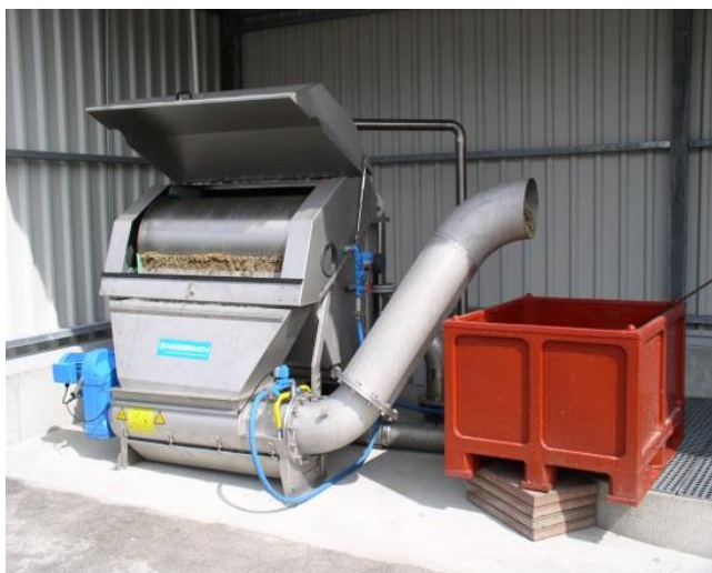
Рисунок 3 – Барабанная решётка механической очистки с интегрированным прессом марки Rotomat
