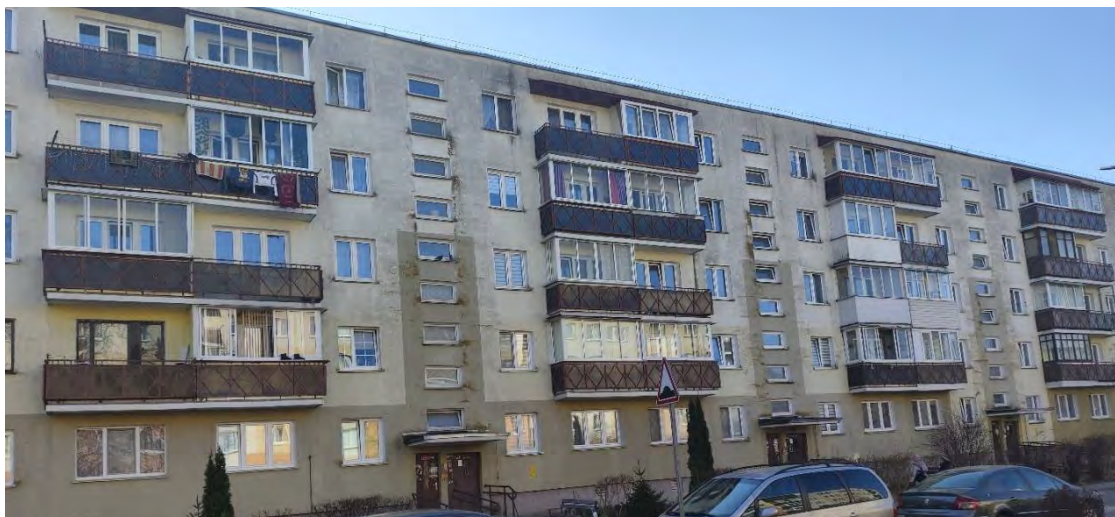
Рисунок 3 – Фрагмент дворового фасада здания по адресу Московская 328/1
