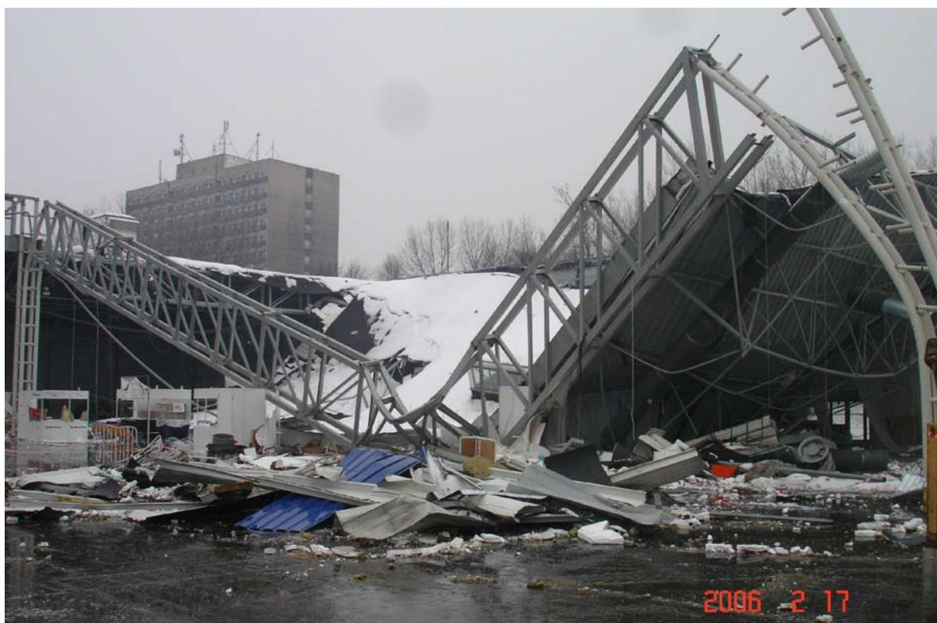
Рисунок 2 – Обрушение крыши выставочного зала г. Катовице, Польша [3]
