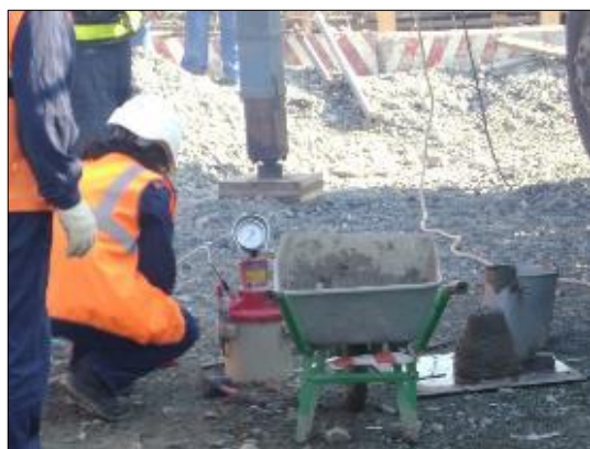
Рисунок 1 – Процесс подготовки (а) и испытание (б) бетонной смеси на объекте
