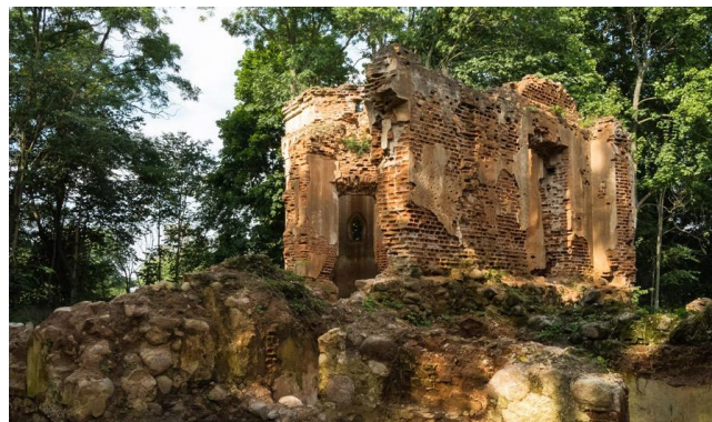
Рисунок 3 – Руины центральной части строения
