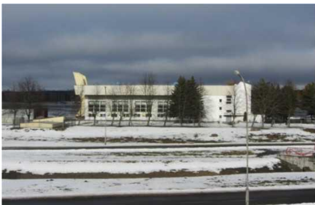
Рисунок 4 – Поверхностный водозабор на водохранилище Дрозды с прямым отбором воды
