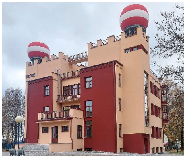
Малюнак 13 – Агульны выгляд будынка пасля рэстаўрацыйных работ 2025 г. (фота аўтара)
