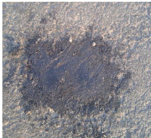
Рисунок 4 – Ямочный ремонт асфальтобетонного покрытия придворовой территории композицией № 9
