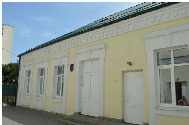
Рисунок 2 – Здание синагоги после реставрации (фасад)
